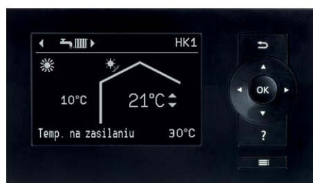
Wyświetlacz regulatora pompy ciepła Vitotronic 200
