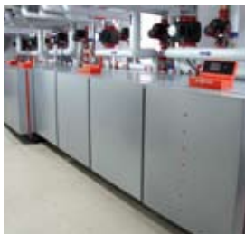
Kaskadę pomp ciepła można precyzyjnie dopasować do występującego zapotrzebowania na ciepło.
