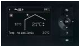
Wyświetlacz regulatora pompy ciepła Vitotronic 200
