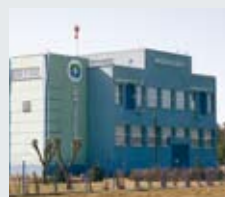
Miejskie Wodociągi i Oczyszczalnia, Grudziądz, Polska
