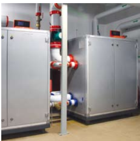
Kaskada dwóch pomp ciepła Vitocal 300-G Pro BW 190 w obiekcie hotelowym
